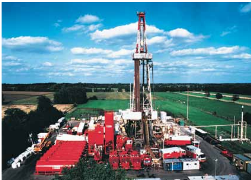
Figura 2.8. Operaciones de cementación.
