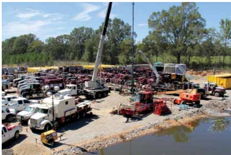
Figura 10.5. Preparativos para un tratamiento de fracturamiento.
